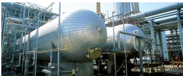
شکل 3- تصویر یک جفت دستگاه دیسالتر الکتریکی در یک واحد نم‌زدایی نفت خام
